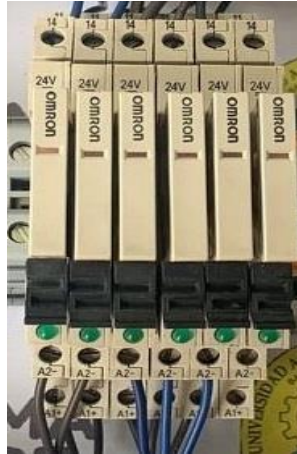
Figura 20. Relé Omron. (Propia autoría).
