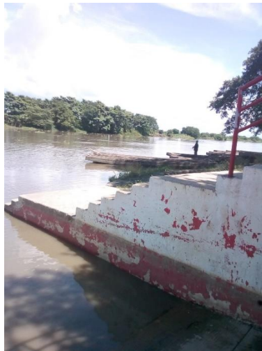
Fig 34. Visita al canal del Dique (Fuente: autor)
