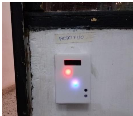
Figura 77. Pruebas del sistema, instalación de router.
