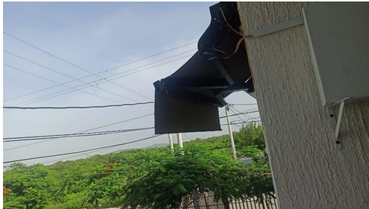
Figura 30. Dispositivo instalado en ventana
