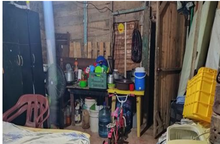
Ilustración 14: Estado actual del interior de las casas de la zona norte del barrio la Cangrejera
