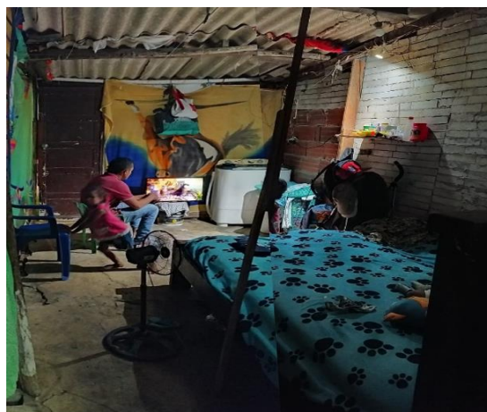
Ilustración 13: Estado actual del interior de las casas de la zona norte del barrio la Cangrejera
