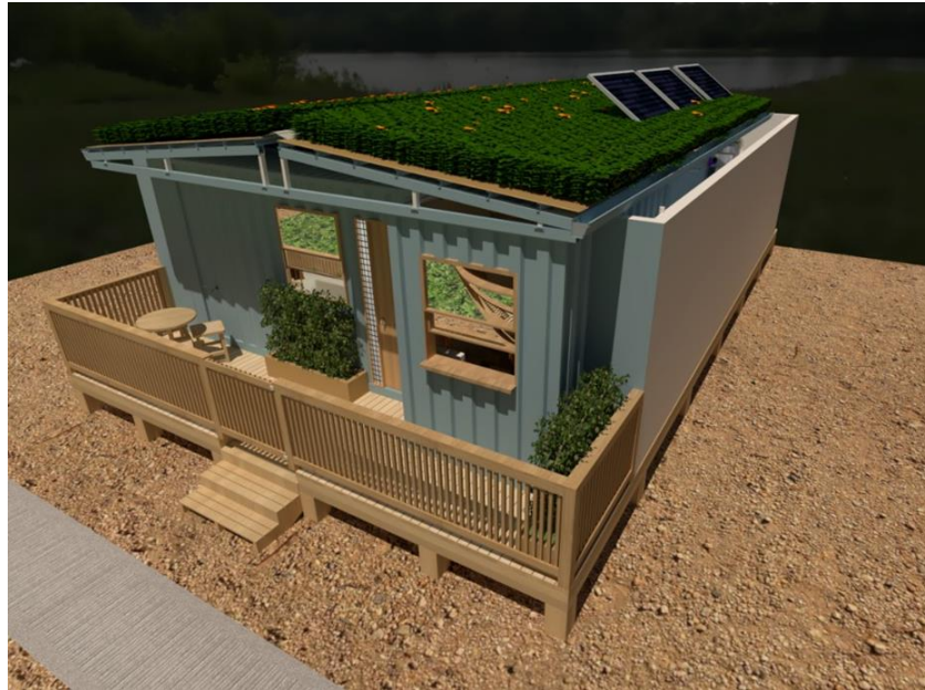
Ilustración 53: Implementación de vegetación en la cubierta
