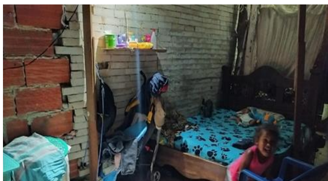
Ilustración 12: Estado actual del interior de las casas de la zona norte del barrio la Cangrejera
