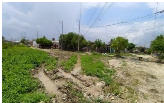
Ilustración 2: Estado actual de las calles del barrio la Cangrejera
