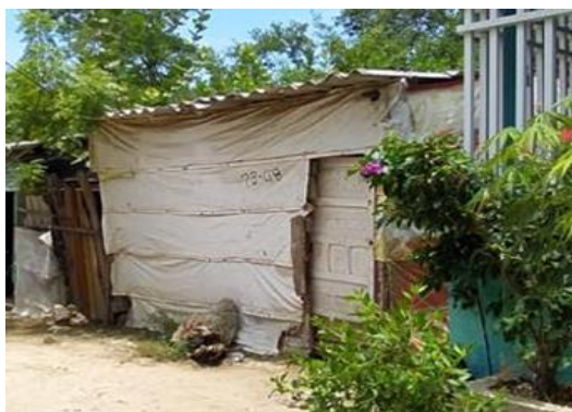
Ilustración 10: Estado actual de las casas de la zona norte del barrio la Cangrejera
