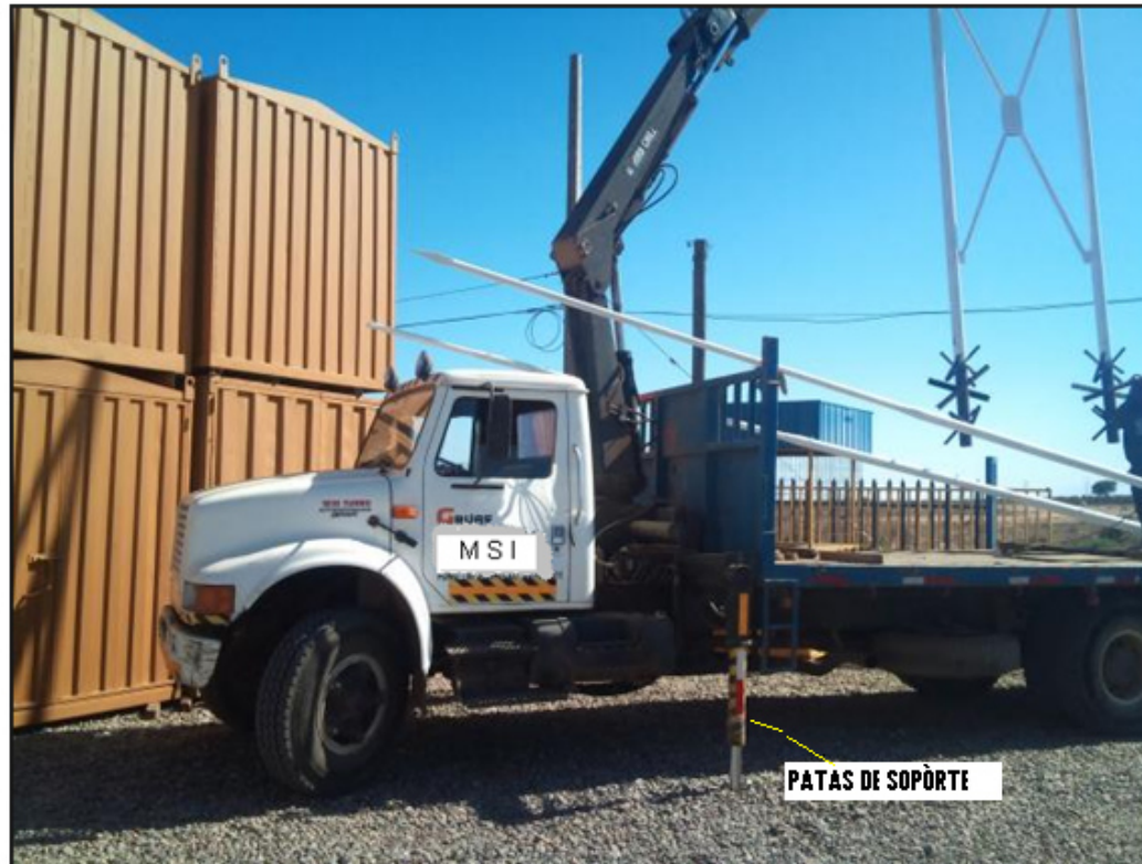
Figura 1. Grúa para servicios eléctricos.
