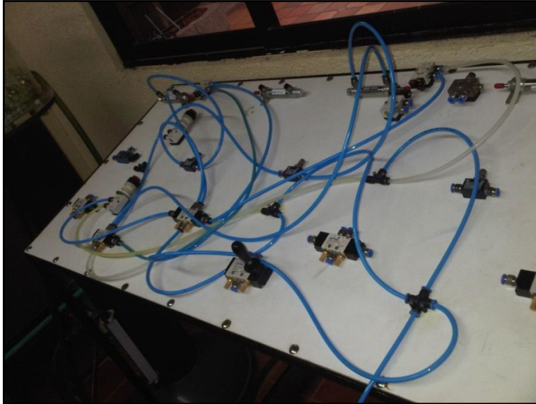
Imagen 65. Montaje del circuito neumático, vista 2.
