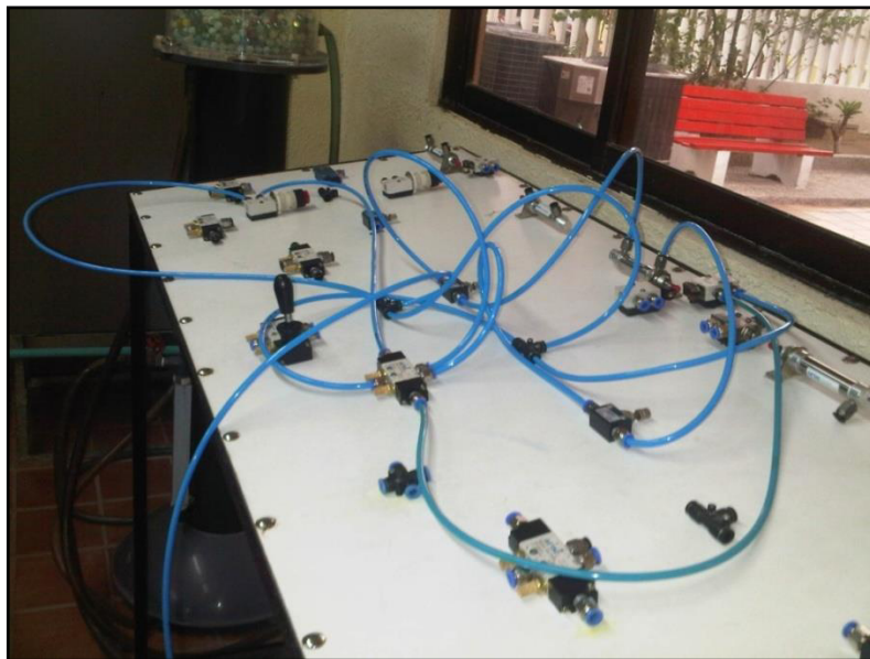
Imagen 62. Montaje del circuito neumático, vista 3.
