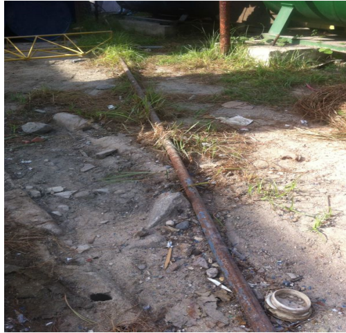
b. Corrosión tubería interna
